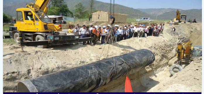
काठमाण्डौको नयाँपाटीमा थोक वितरण प्रणाली अन्तर्गत खानेपानीको पाइपलाइन जडान गरिदै
